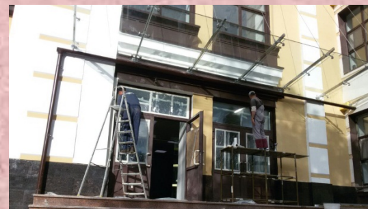
Козырёк - навес Последний переулок, г. Москва
